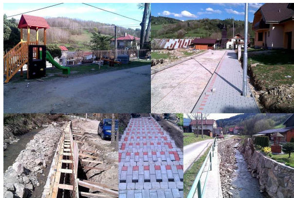
Obr. Práce realizované v obci Hraničné
