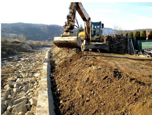
Obr. Ilustračná fotografia z realizácie stavby
