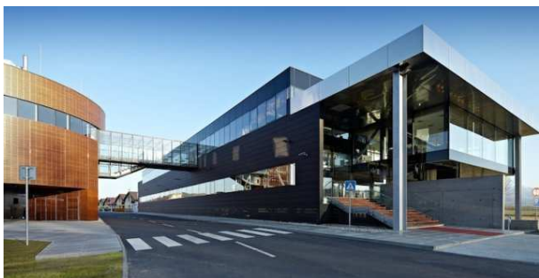
foto: Stavba roka 2012
